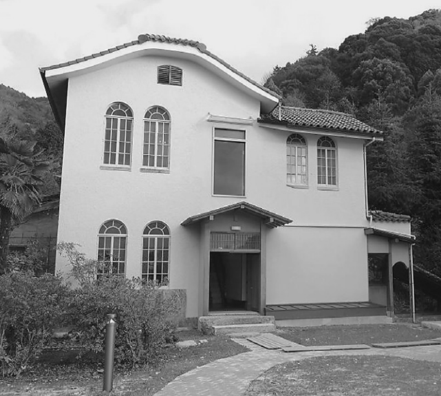
修復された和中庵
