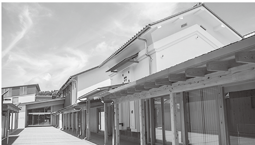
中央玄関へのアプローチ
