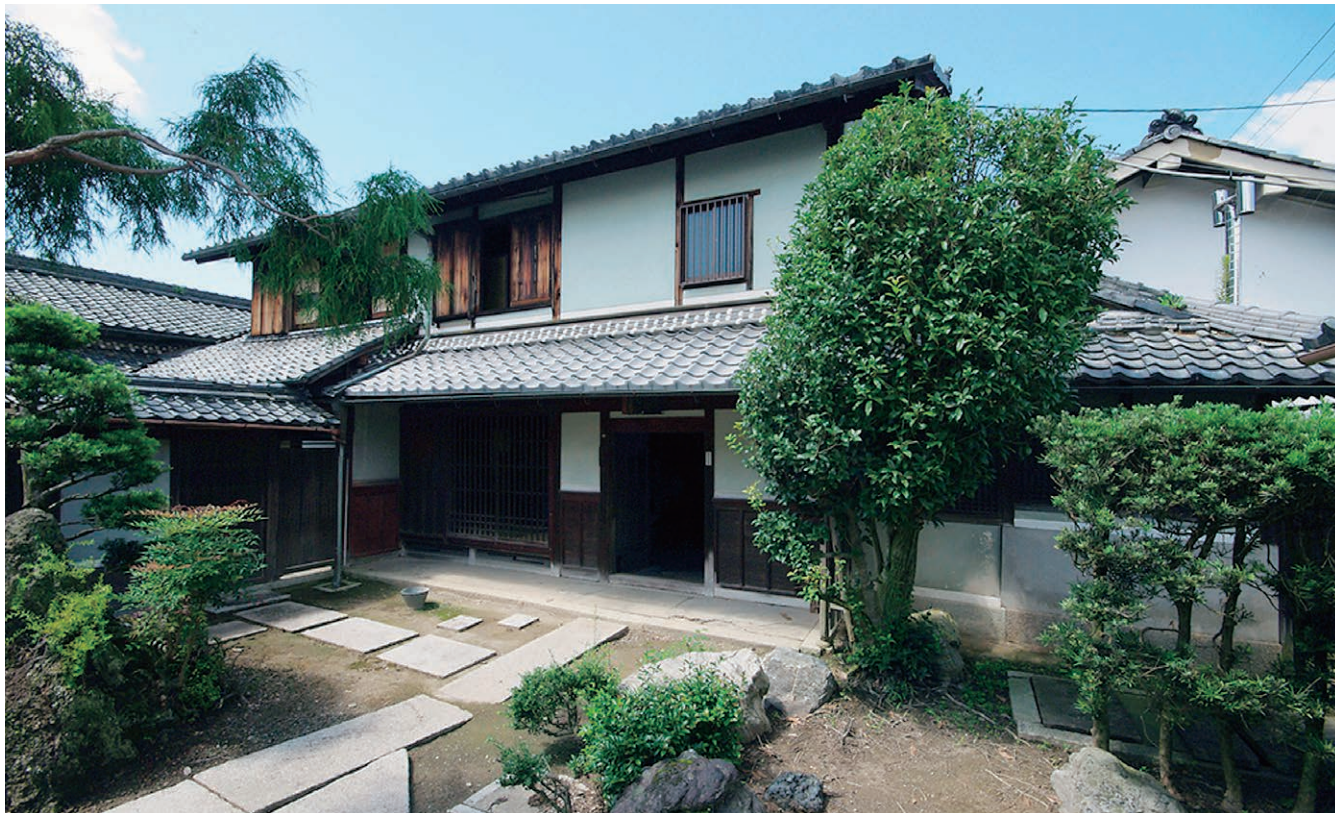
国指定登録文化財の小泉重助家主屋。4間取型で2階にも座敷飾りの整った居室を持つ主屋。小家蔵や辰巳蔵といった土蔵群のほか、納屋などの附属建物、表門や平などの屋敷構えが一連としてよく残っている。写真提供：近江商人博物館
